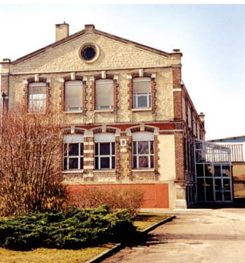
L'usine Jannet, rue Etienne Pédron, Troyes, actuel SDIS, a abrité les Archives départementales de l'Aube. (Cl. J.L. Humbert, mars 2003)
