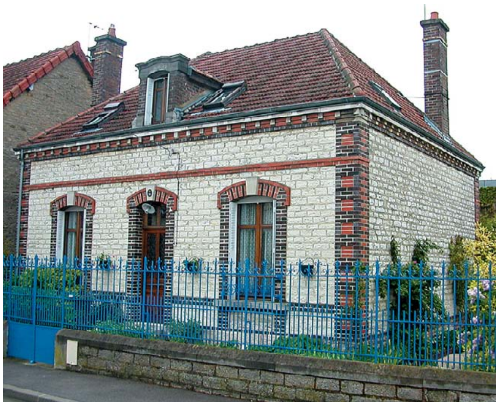
Maison du lotissement Vanderbach, rue Vanderbach.
