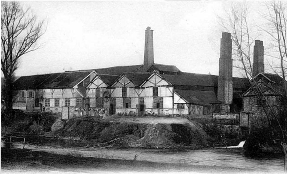
Forges de Plaines. Cette usine appartient à la Compagnie des Forges de Châtillon-Commentry. Tréfilerie très active durant tout le XIX e siècle, elle emploie 100 à 150 personnes, logées pour partie dans les maisons érigées par la compagnie. (Arch. dép. Aube, 8 Fi 6309).
