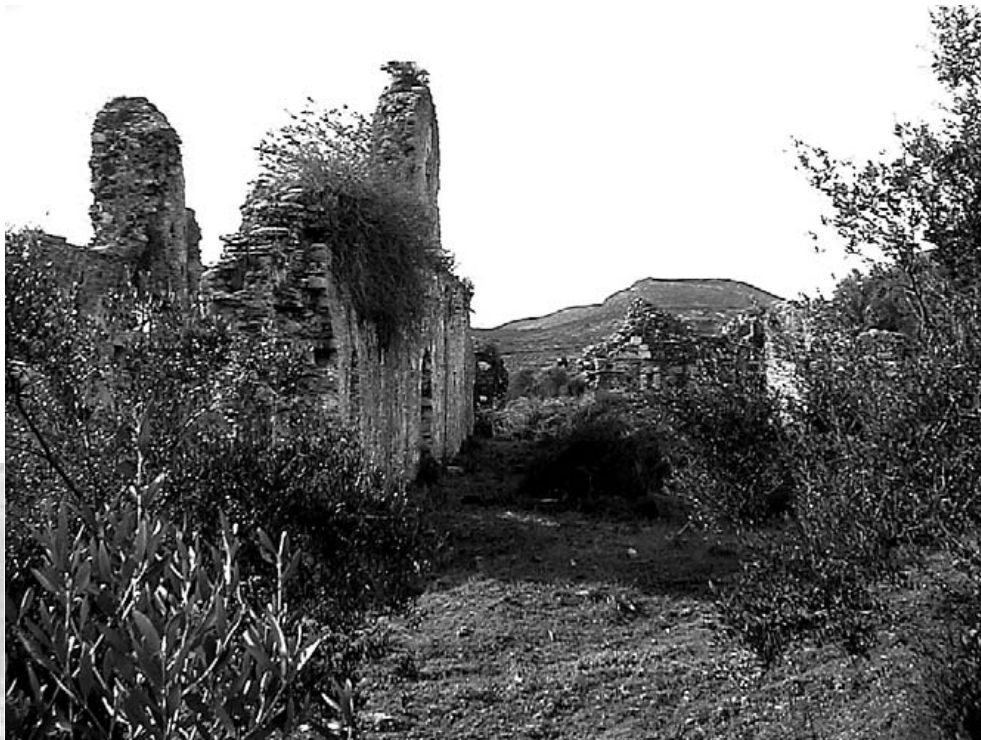
Vue intérieure de l'abbatiale avec à gauche, l'église vénitienne.
